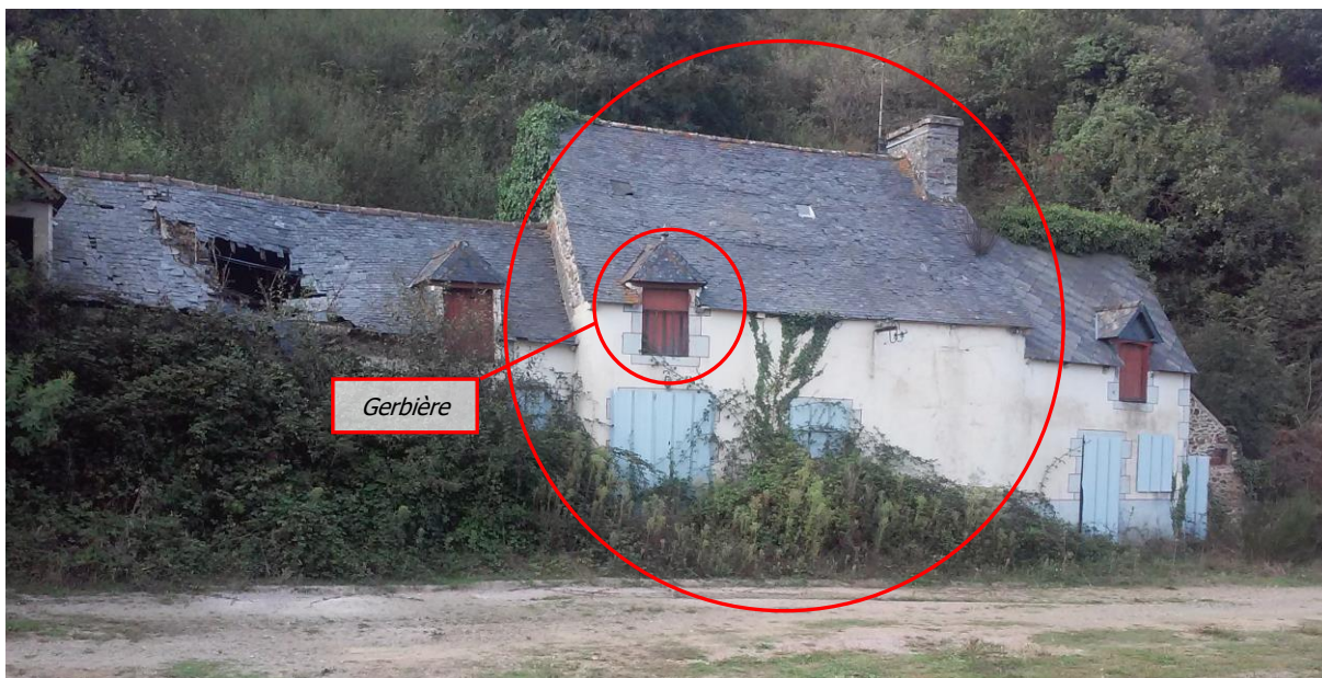
Vue du bâtiment abritant la colonie de petit rhinolophe
