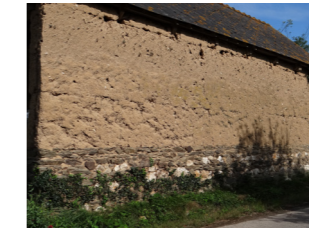
137. Bâti en terre (Quillien)
