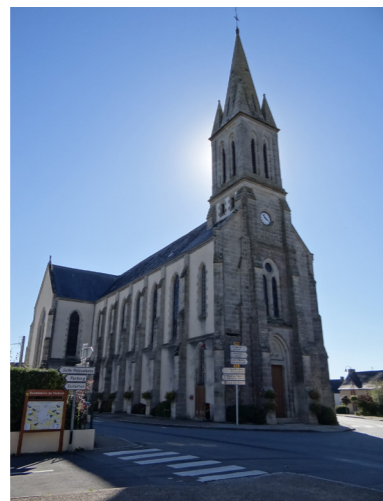
136. Eglise de Mohon
