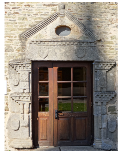
135. Porte de la maison du Sénéchal
