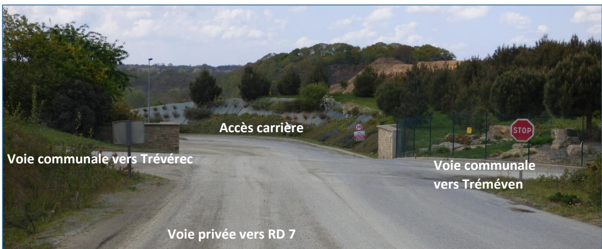
Fig. 26 : Vue B sur l'entrée de la carrière depuis la voie privée
