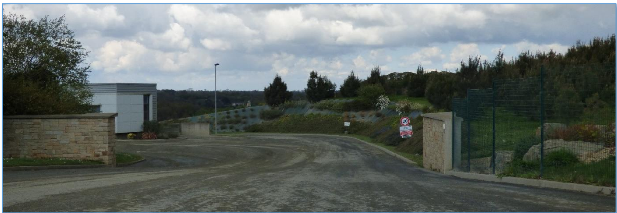
Fig. 36 : Vue sur l'accès au site, fermé par un muret, une clôture et un portail (hors période d'activité)
