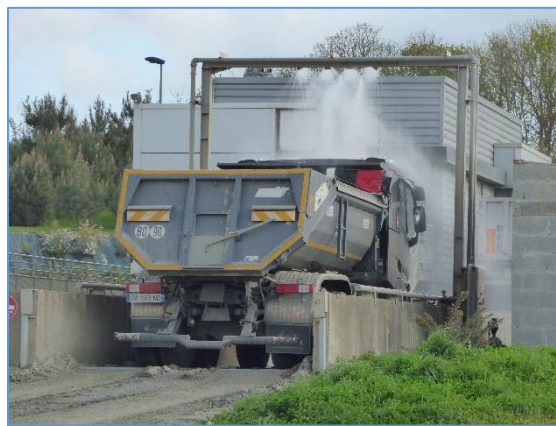
Fig. 16 : Vue sur le portique d'aspersion du chargement des camions
