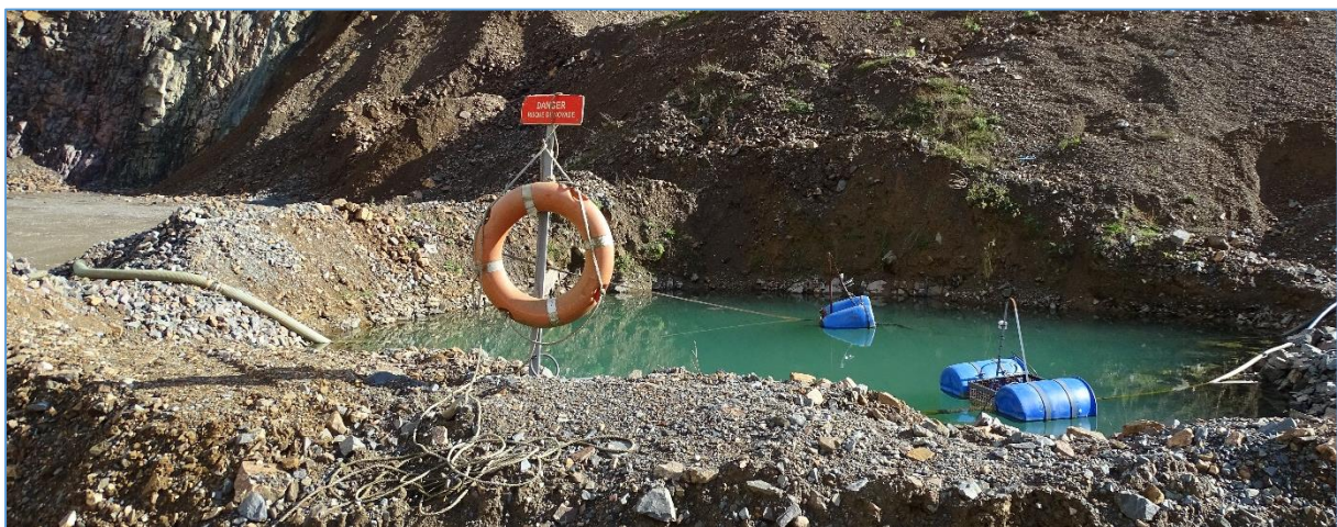
Fig. 11 : Merlon et bouée en bordure du bassin d'eau claire
