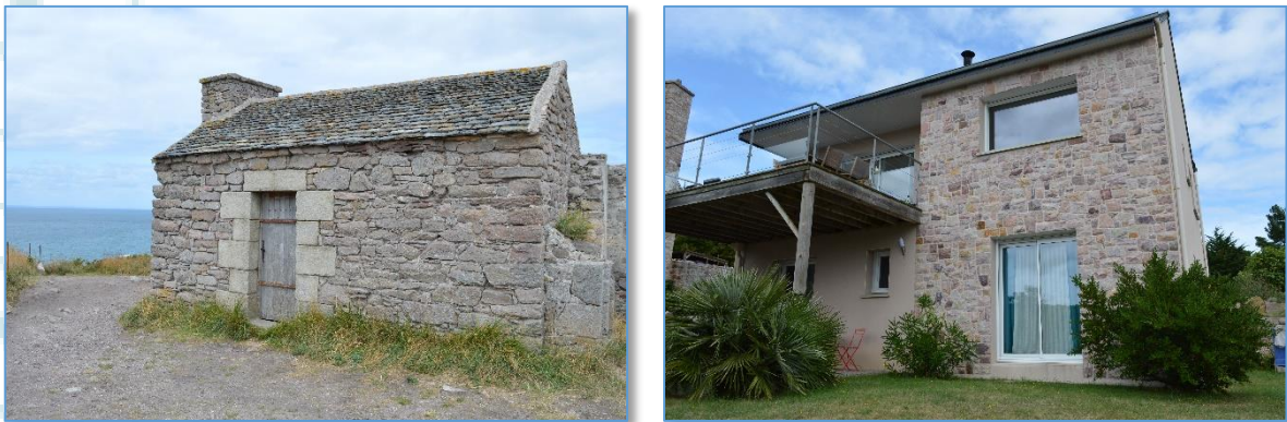
Fig. 19 : Vue sur le bâti en grès d'Erquy à gauche bâti ancien : corps de garde, à droite, bâti récent : hameau de Tu Es Roc
