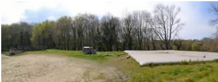
Photo n° 02 : Vue sur la poche de stockage à l'extrême Nord du Site.
