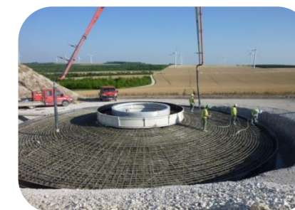
Coulage de la fondation
