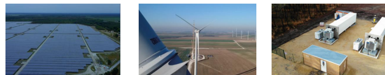
Figure 3 : de gauche à droite, Centrale Solaire de Cestas (300 MWc), Centrale Eolienne de Bussy-Lettrée (26 MW), et Azur Stockage (6 MW, 6MWh) (source : NEOEN, 2019)
