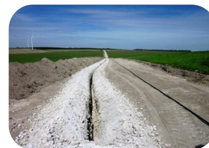
Réalisation des pistes et du câblage
