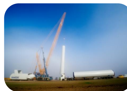
Livraison et Montage des tronçons de mâts
