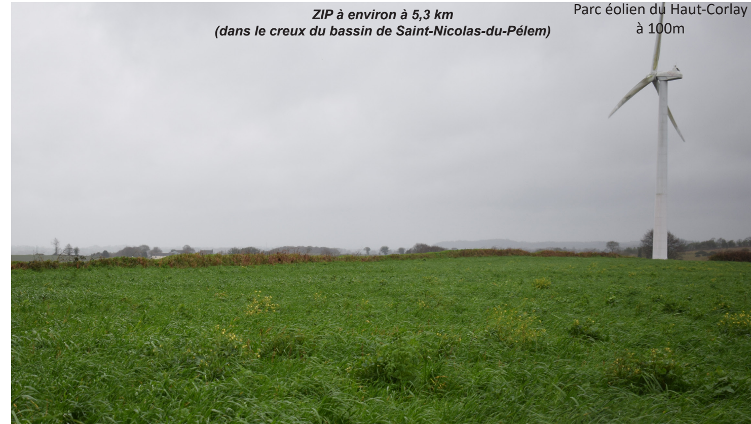
Figure 42 : Abords du parc éolien du Haut-Corlay Le parc éolien du Haut Corlay s'inscrit sur les hauteurs du Mené, à proximité de la cime de Kerchouan. La ZIP du projet Neo Avel est, quant à elle, située en zone basse dans le bassin de Saint-Nicolas-du-Pélem. Cette situation en creux du projet par rapport aux parcs éoliens situés sur les lignes de crête, permet ainsi d'envisager une limitation des effets de cumul visuel.
