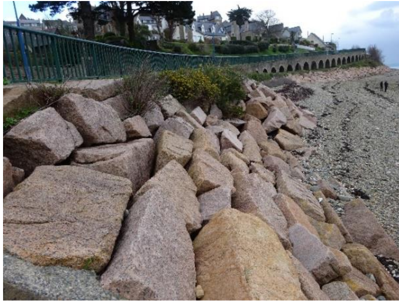
Fig. 9. Enrochements de la plage des Arcades
