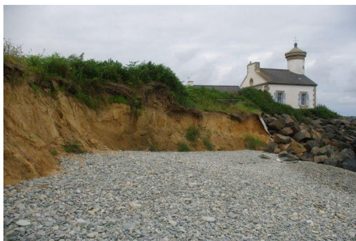
Fig. 4. Érosion au phare de Nantouar
