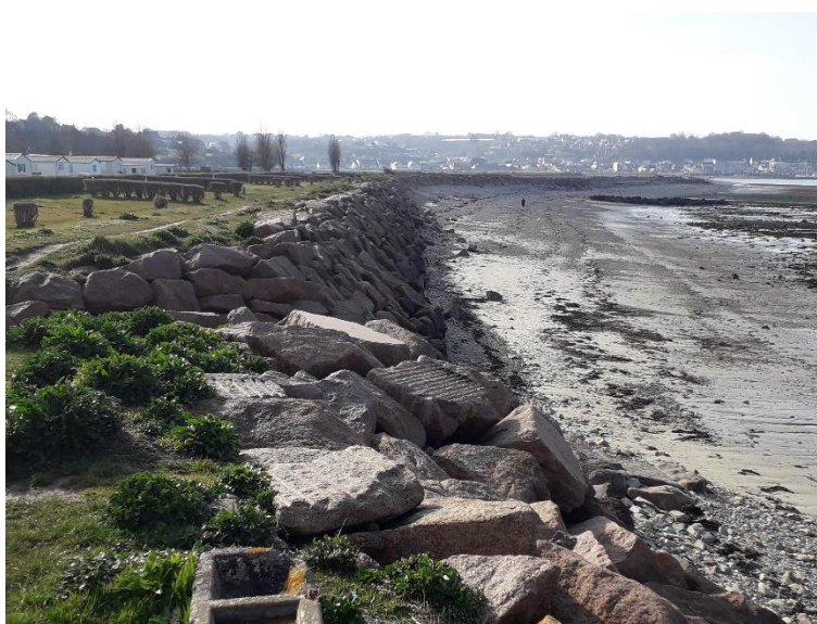
Fig. 7. Enrochements de la digue du Lenn
