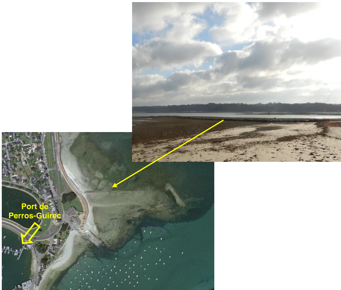
Fig. 10. Digues en mer du Linkin
