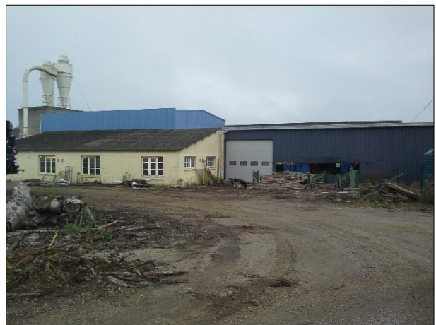
Photo 4 : Vue Sud des bâtiments
