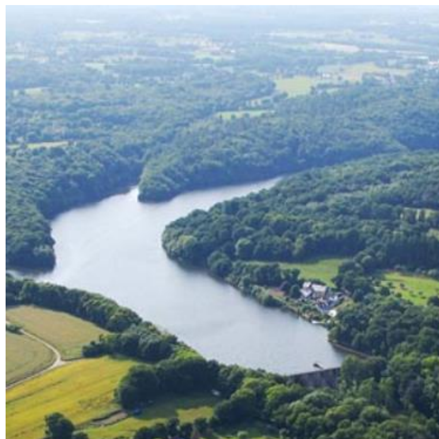
Figure 113 : Photo aérienne barrage du pont Ruffier sur le Guinefort (Sources Randogs.net-2017)
